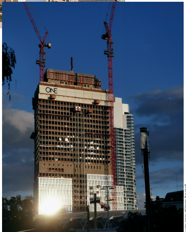
Abendlicher Blick auf die Baustelle des ONE
