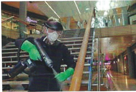
Aufbringen der Beschichtung TiTANO in der Europapassage in Hamburg auf sämtliche Oberflächen inkl. der Aufzugsknöpfe (Quelle: UVIS)
