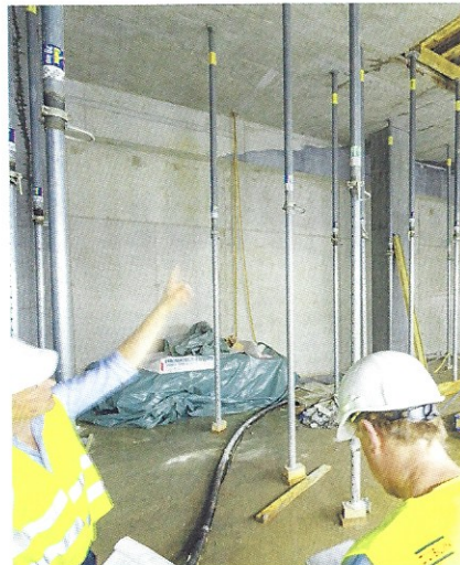
„Regiezentrale“: Blick in den zukünftigen Technikraum. Foto: Hans-Wilhelm Berghoff
